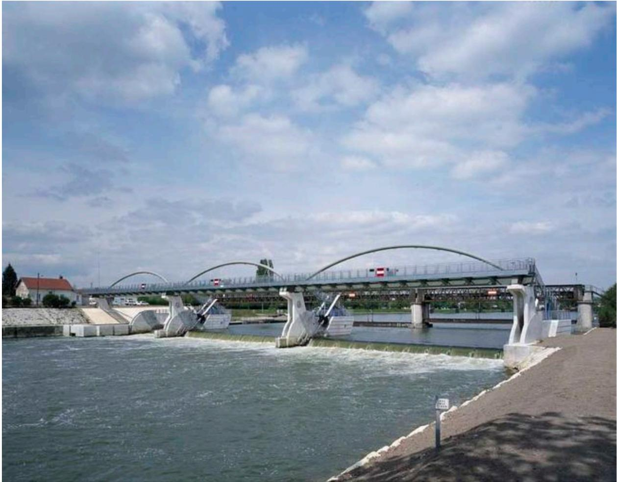
Creil : barrage à clapets.
