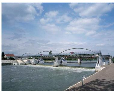
Creil : barrage à clapets.
