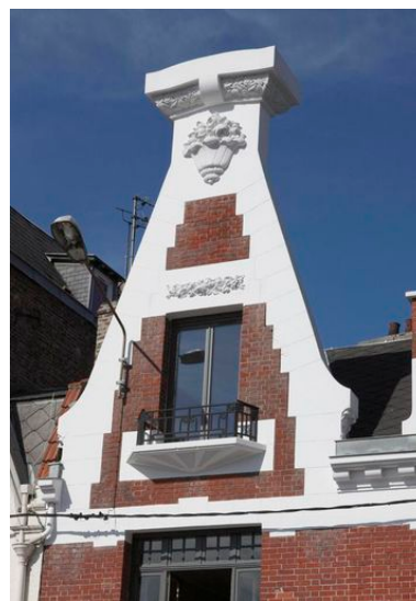
Pignon empreint de régionalisme flamand et de style Art déco. Phot. Pierre Thibaut IVR31_20096200204NUCA
