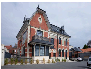
Façade sur cour. Phot. Hubert Bouvet IVR32_20196200643NUC4A
