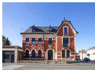
Façade principale, vue depuis la rue du faubourg de Péronne. Phot. Hubert Bouvet IVR32_20196200621NUC4A
