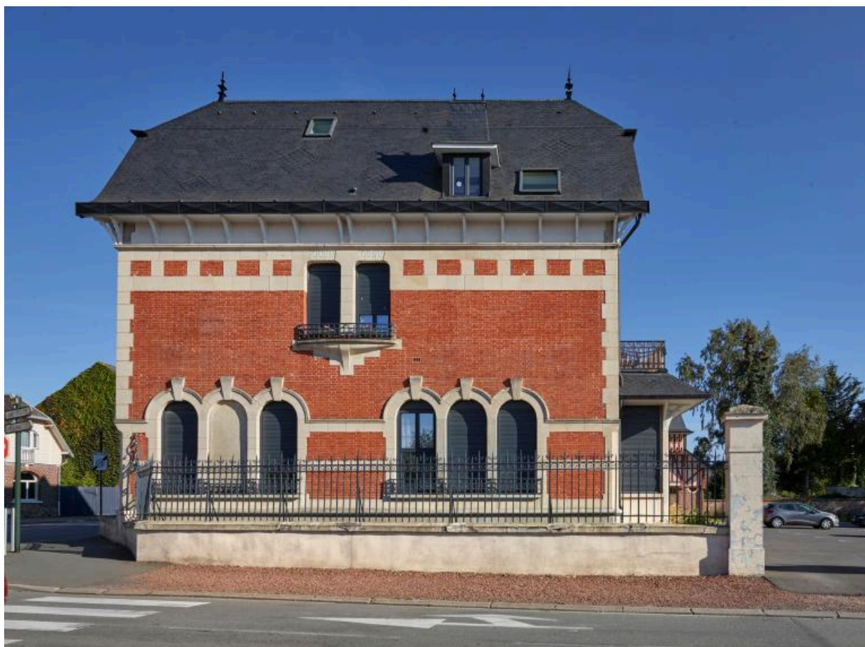
Façade latérale droite depuis la rue du Général Leclerc.
