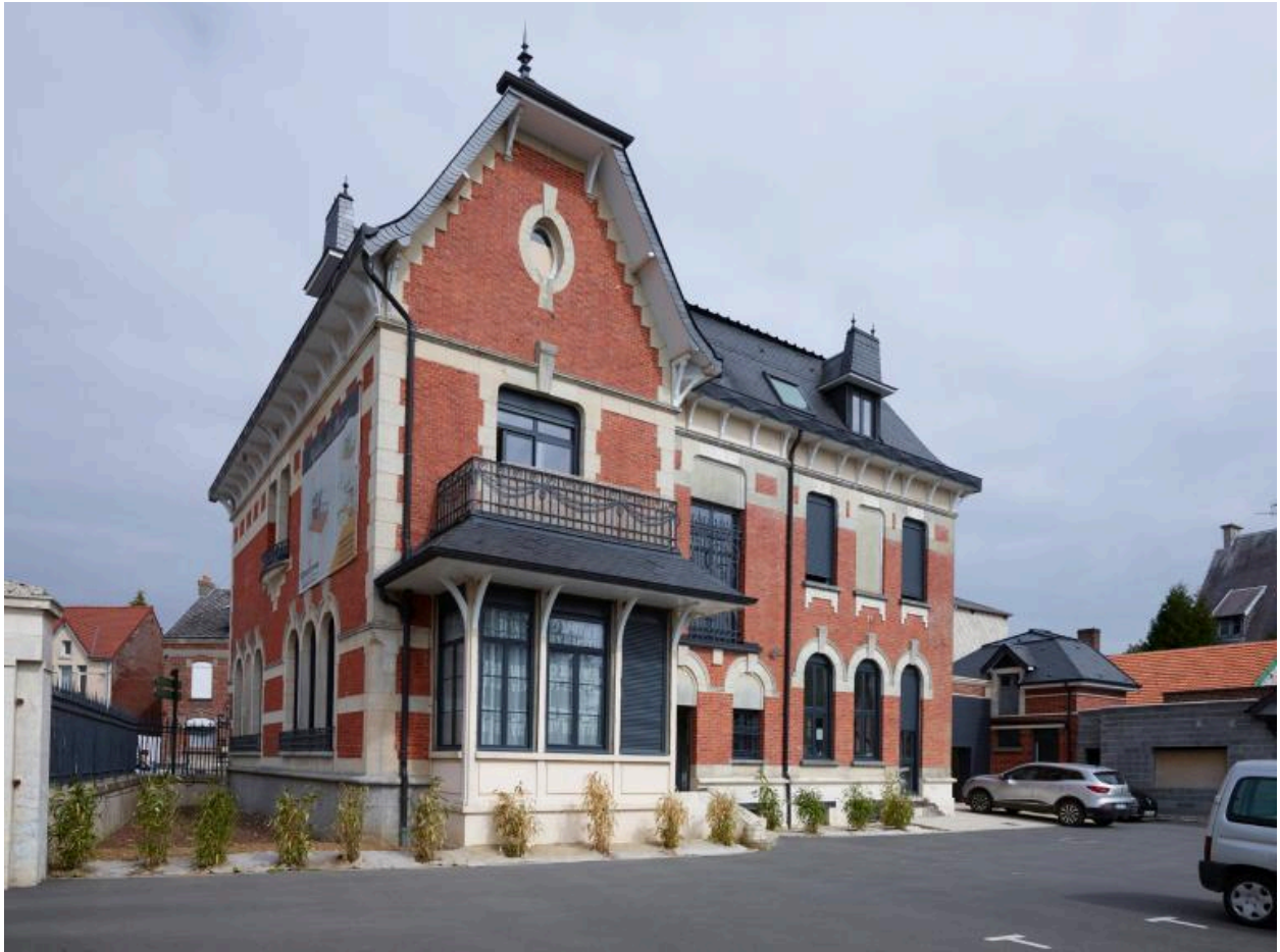
Façade sur cour.
