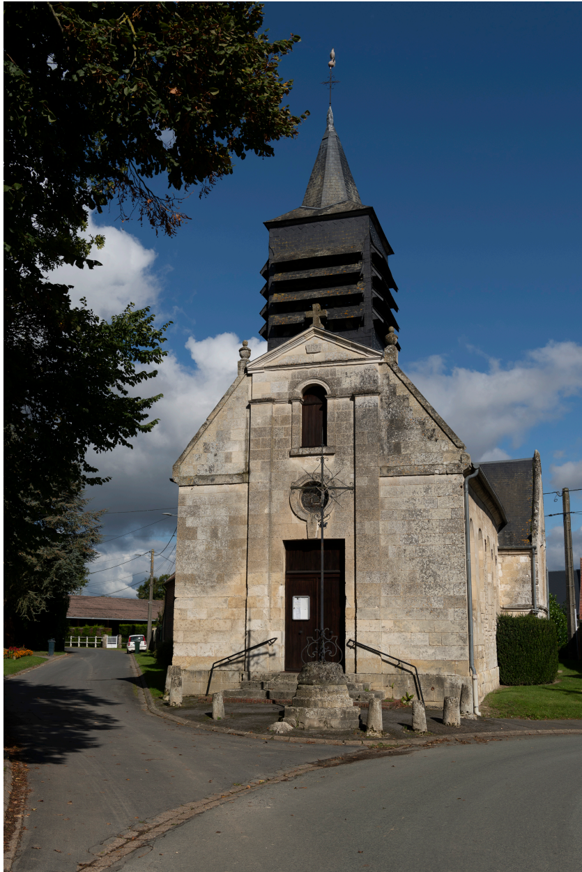
Vue générale de l'élévation occidentale.
