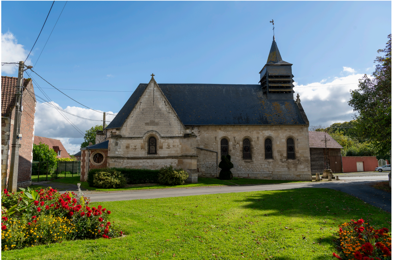
Vue générale de l'élévation nord.
