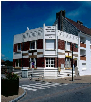
Vue d'ensemble sur le pan coupé. Phot. Marie-Laure Monnehay-Vulliet IVR22_20038000615XA
