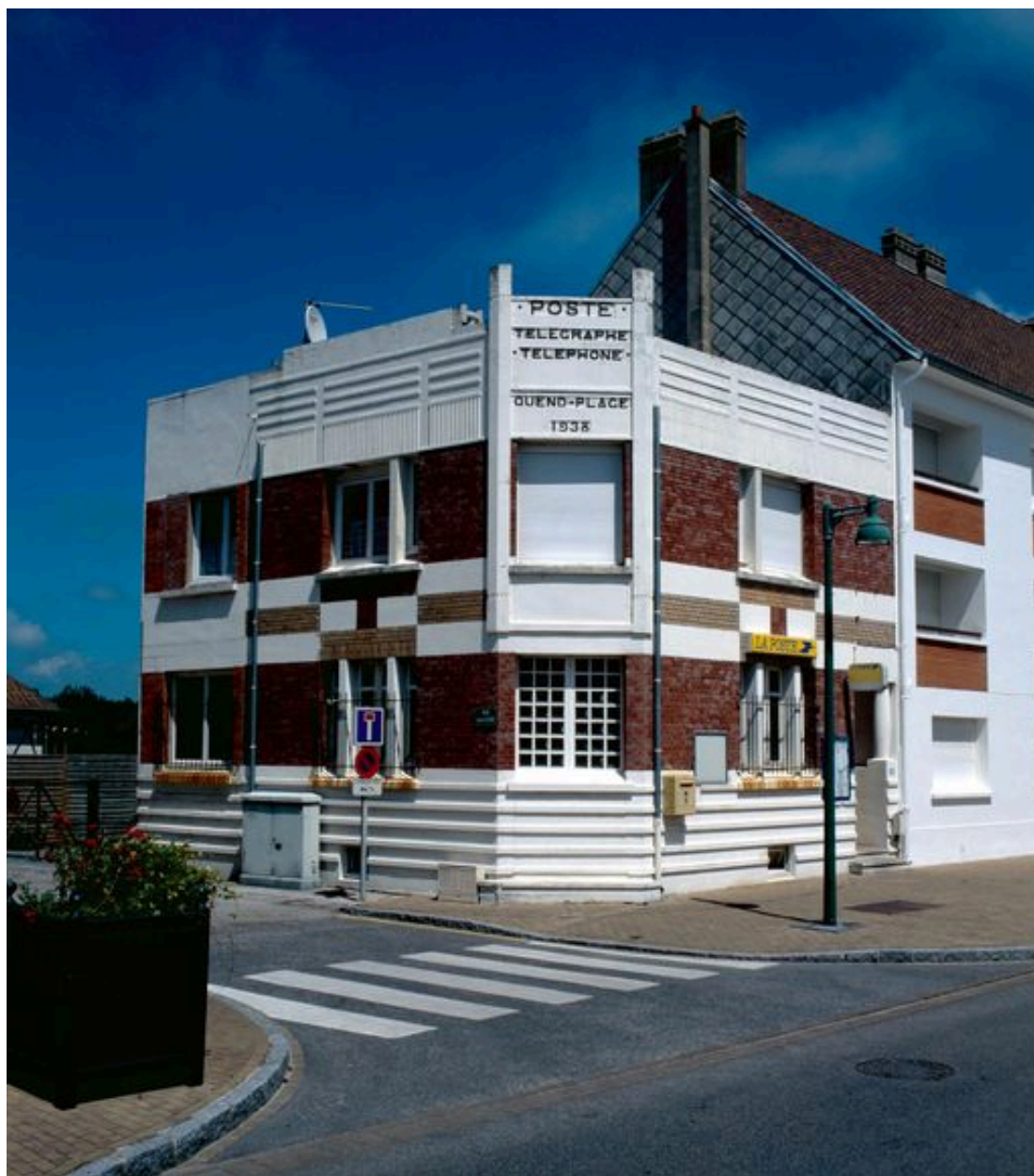
Vue d'ensemble sur le pan coupé.
