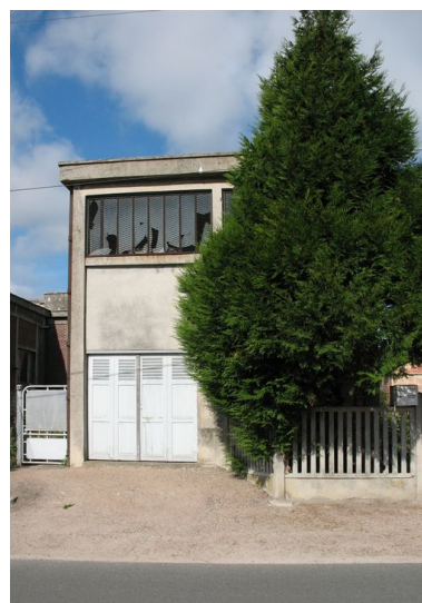
Transformateur électrique de la station de pompage. Phot. Clarisse Lorieux IVR22_20096005174NUCA
