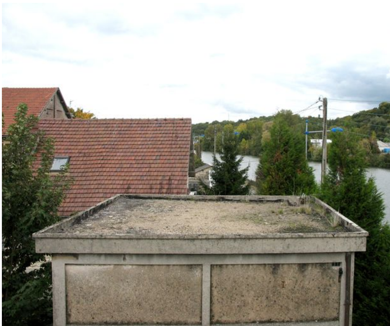
Toit terrasse du transformateur.
