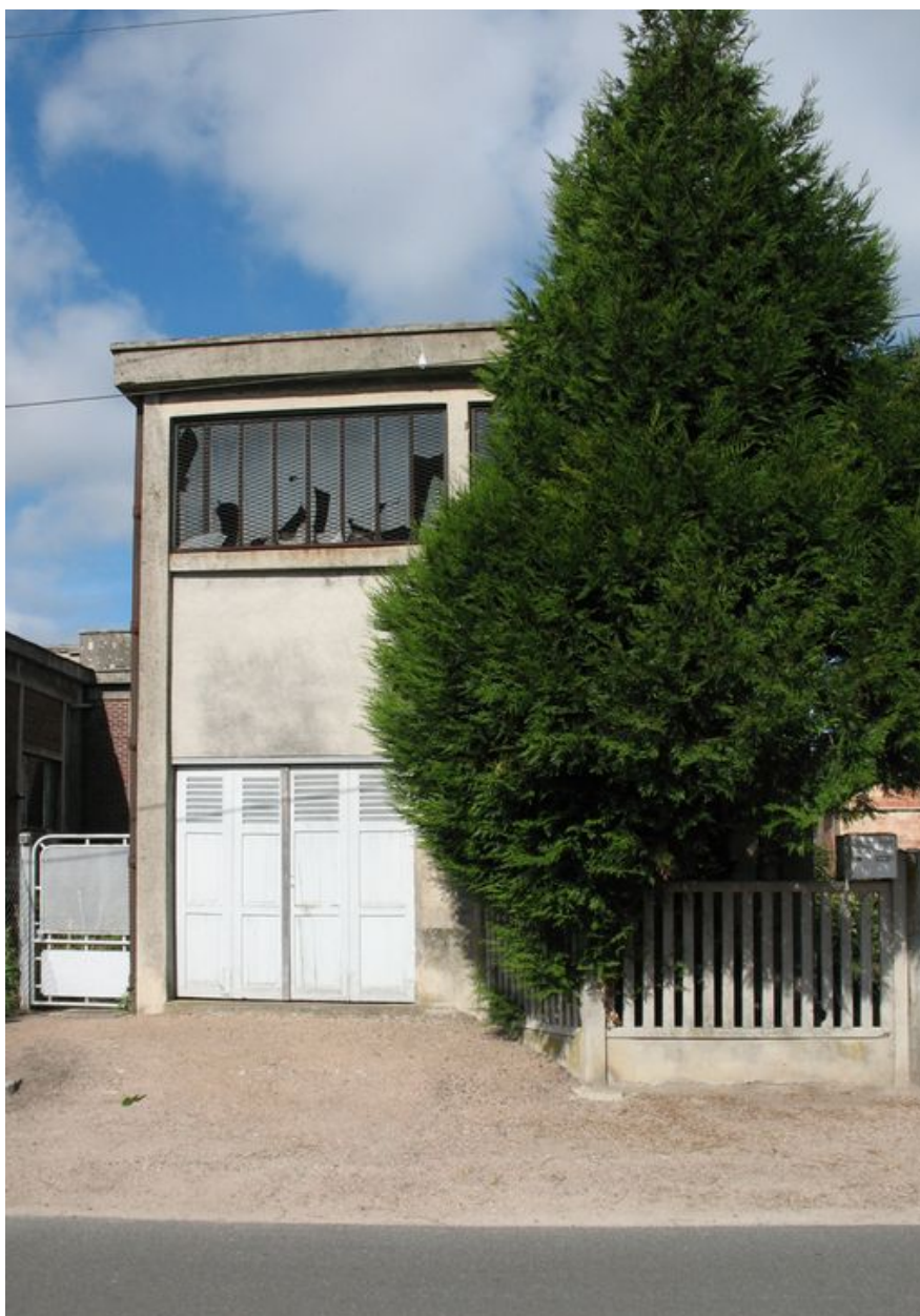
Transformateur électrique de la station de pompage.
