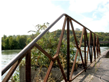
Détail du garde-corpe en fonte. Phot. Clarisse Lorieux IVR22_20096005179NUCA
