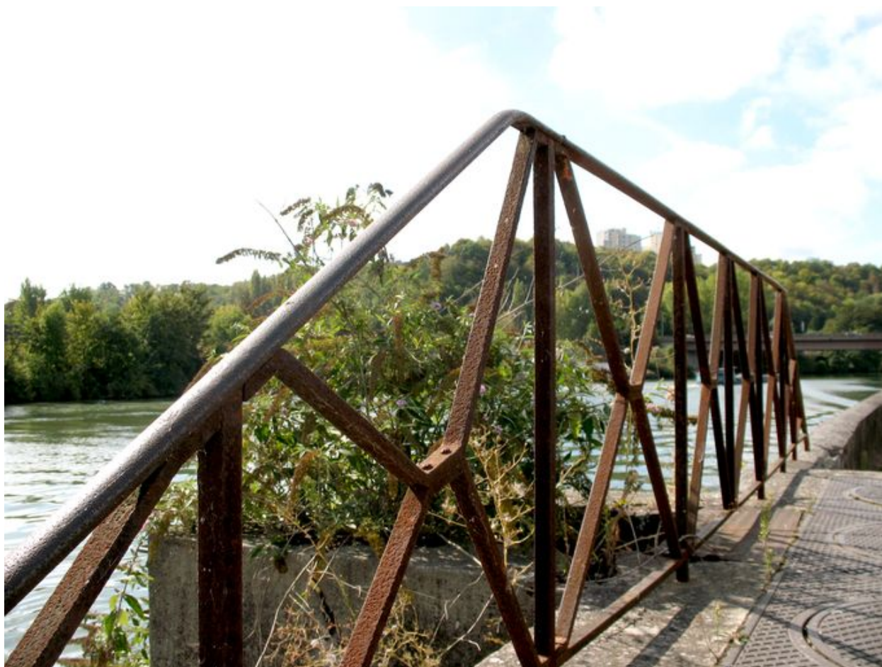
Détail du garde-corpe en fonte.
