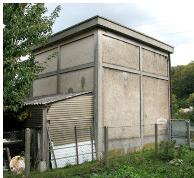
Le transformateur électrique vu vers l'Oise. Phot. Clarisse Lorieux IVR22_20096005175NUCA
