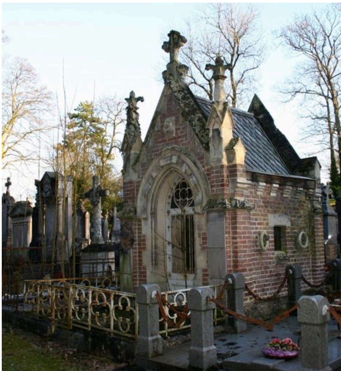
Vue générale, depuis le côté.
