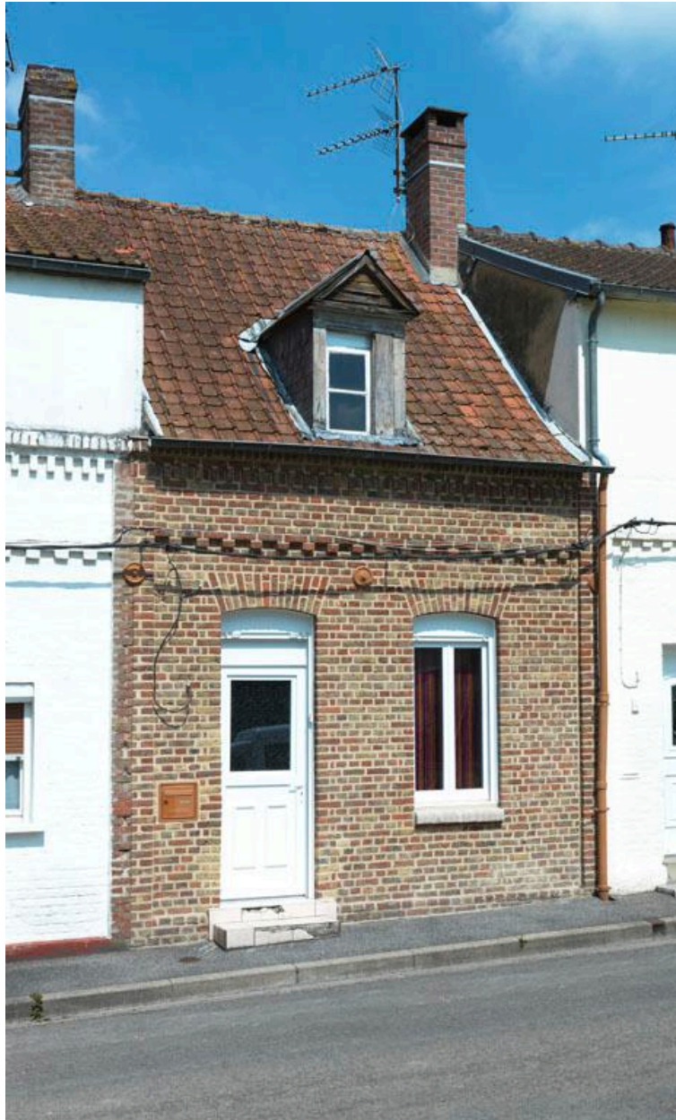
Façade sur rue du logement 247, rue des Prés, vue de trois-quarts.
