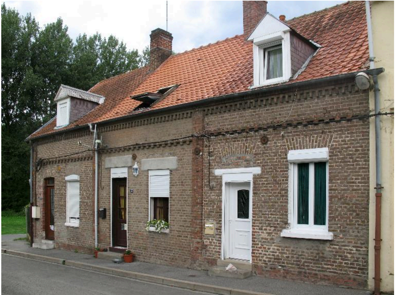
Façades sur rue des logements 235 à 239 rue des Prés.
