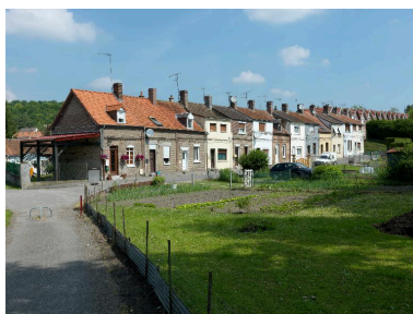
Vue d'ensemble de la cité ouvrière et ses jardins à l'avant. Phot. Thierry Lefébure IVR22_20128000282NUC2A
