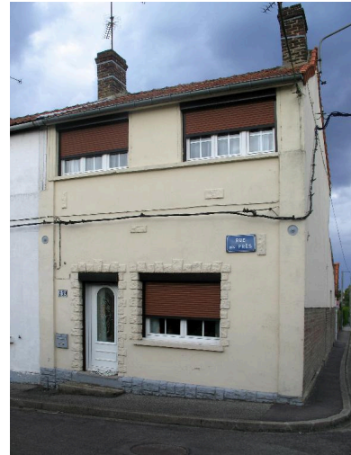
Façade sur rue du logement ouvrier 259 rue des Prés. Phot. Bertrand Fournier IVR22_20128005075NUCA
