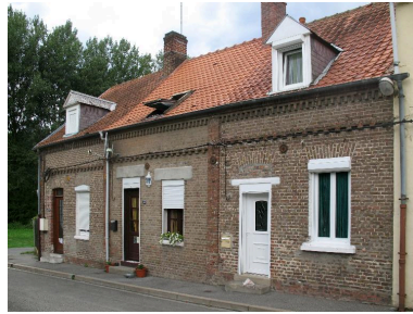
Façades sur rue des logements 235 à 239 rue des Prés. Phot. Bertrand Fournier IVR22_20128005074NUCA
