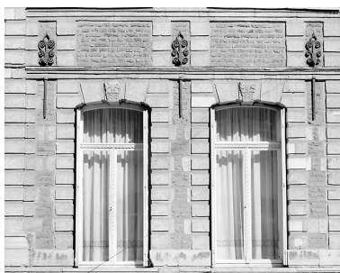
Façade rue Notre-Dame, détail : travées 5 et 6 en partant de la gauche, rez-de-chaussée. Phot. Pierre Thibaut IVR31_20015901228X
