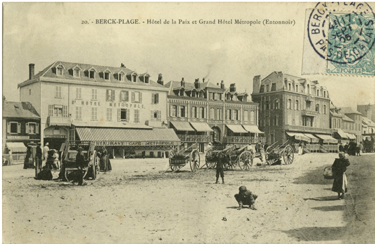
Grand hôtel Métropole, devenu ensuite l'institut Notre-Dame-des-Sables, avec, sur la droite, l'institut Notre-Dame, élévations antérieures sur l'Entonnoir, vue d'ensemble prise de trois-quarts gauche. Carte postale, début du 20e siècle(coll. part).
