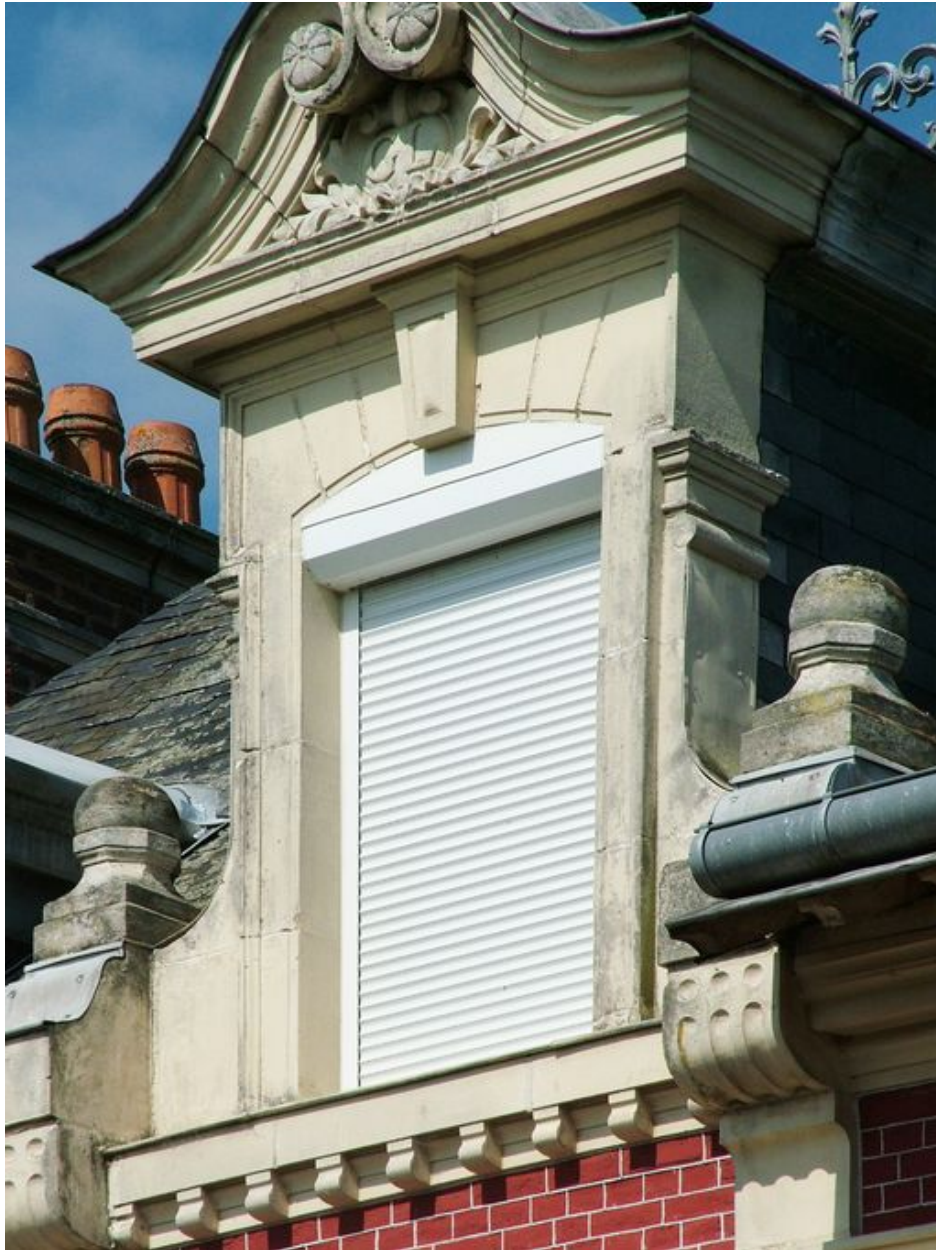
Détail de la lucarne portant les initiales : G. L.
