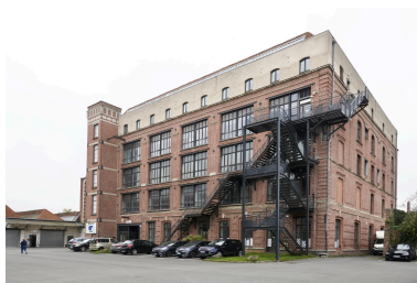
Vue générale du bâtiment avec sa tour. Phot. Delphine Volto Jourdan IVR32_20265900105NUCA
