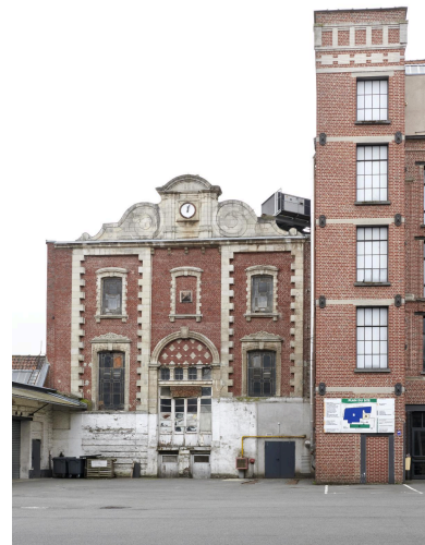
Vue sur la chaufferie adjacente et sur la tour du bâtiment de tissage. Phot. Delphine Volto Jourdan IVR32_20265900096NUCA
