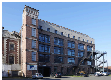
Vue générale du bâtiment, vue sur cour intérieure. Phot. Delphine Volto Jourdan IVR32_20265900576NUCA
