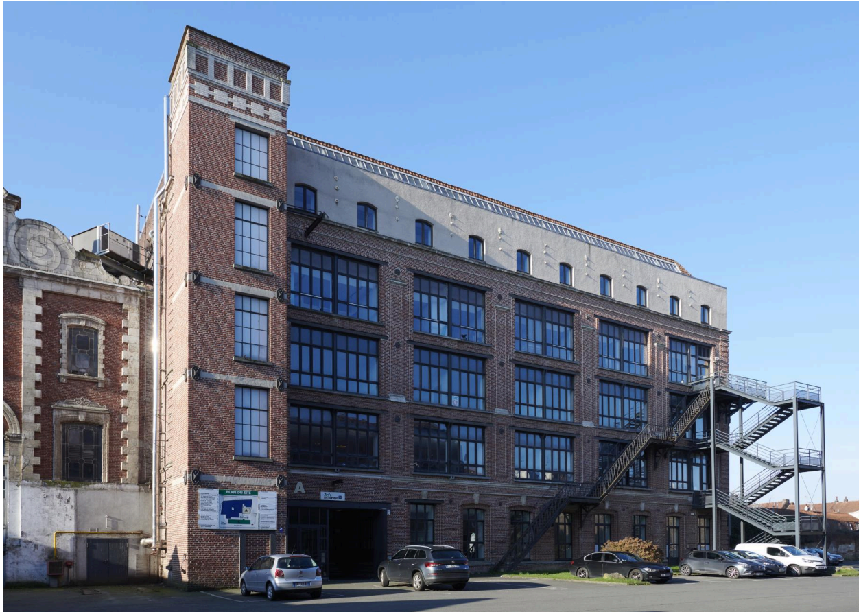
Vue générale du bâtiment, vue sur cour intérieure.
