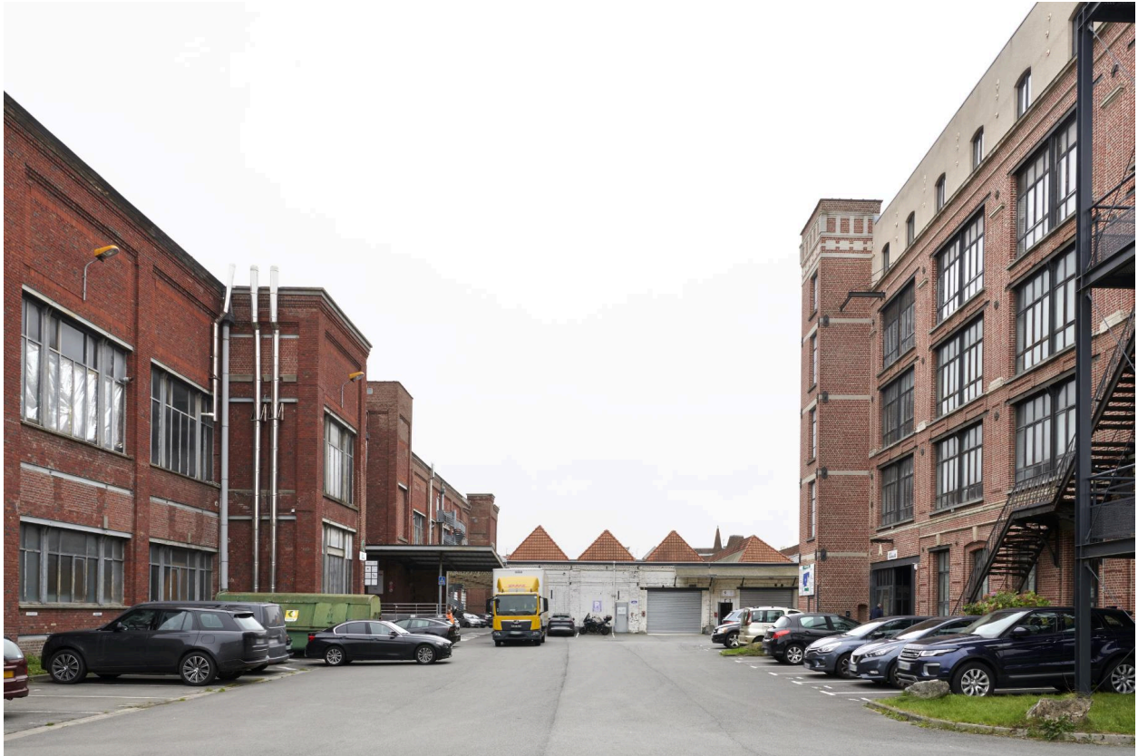
Bâtiments sur la cour intérieure, vue générale.
