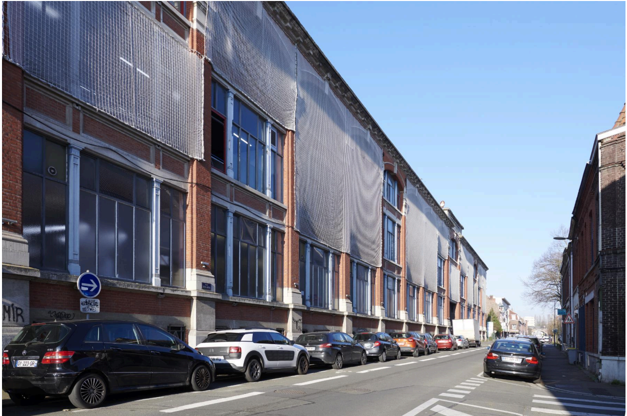
Vue générale nord-ouest, façade principale sur rue des Arts.
