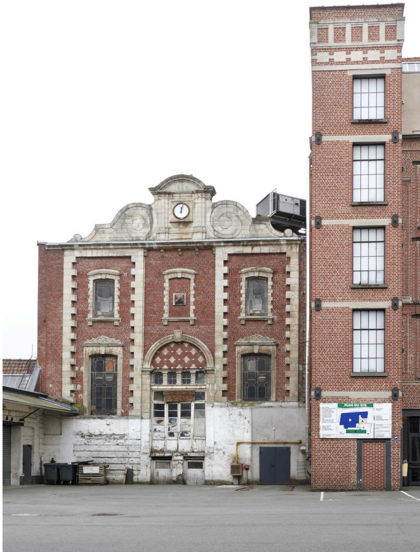
Vue sur la chaufferie adjacente et sur la tour du bâtiment de tissage.
