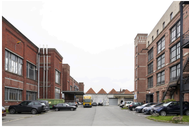
Bâtiments sur la cour intérieure, vue générale. Phot. Delphine Volto Jourdan IVR32_20265900104NUCA
