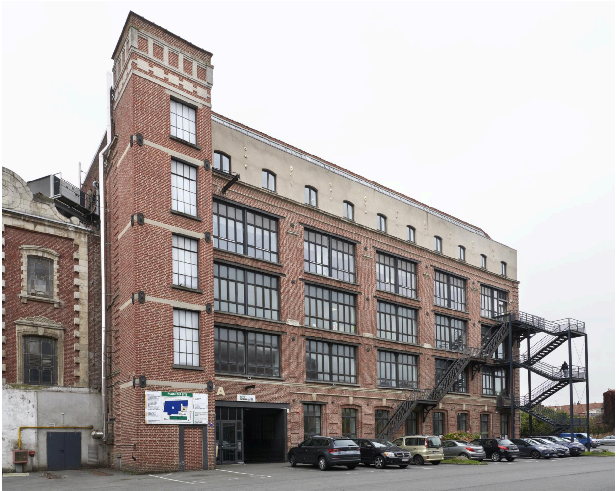
Vue de la tour et du bâtiment sur la cour intérieure.
