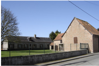
Vue générale. Phot. Inès Guérin IVR22_20058005476NUCA
