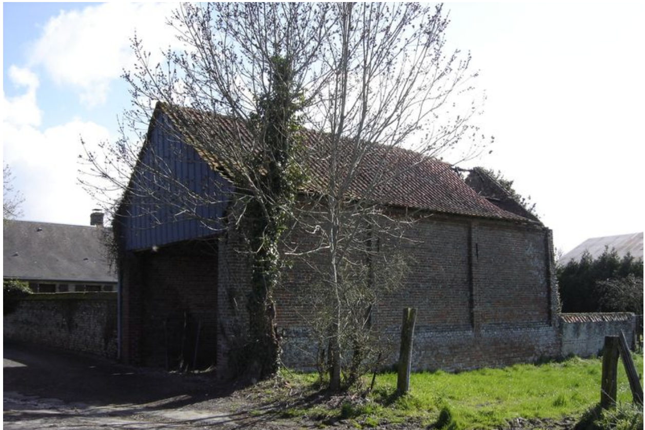
Vue du hangar en fond de parcelle.
