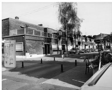
Bloc 3 de l'îlot D : alignement postérieur.
