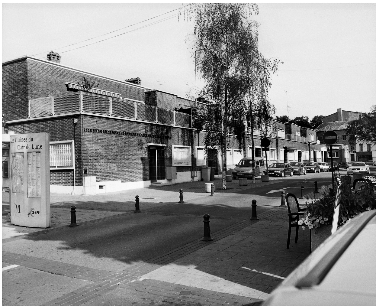
Bloc 3 de l'îlot D : alignement postérieur.
