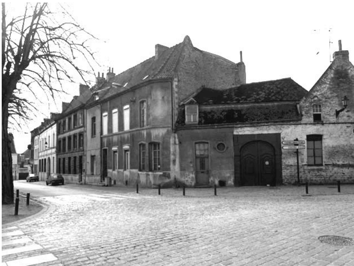
Côté sud-ouest de la place : vue générale.
