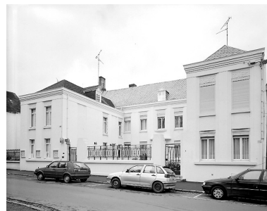
Côté nord-ouest de la place : n° 6-8-10, hôtel canonial. Phot. Pierre Thibaut IVR31_20005902409V
