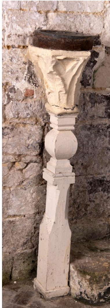
Ancien bénitier avec réemploi d'un chapiteau du chœur (dernier quart 12e siècle). Phot. Marc Kérignard IVR32_20216000654NUCA
