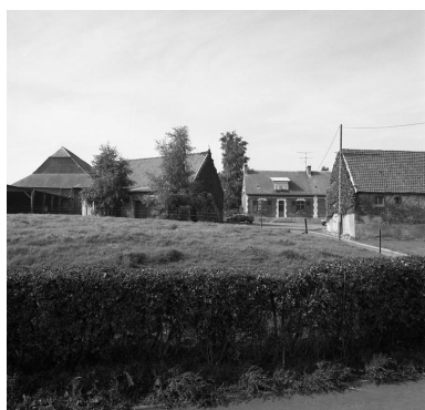
Vue de situation. Phot. Thierry Lefébure IVR22_19960200645X
