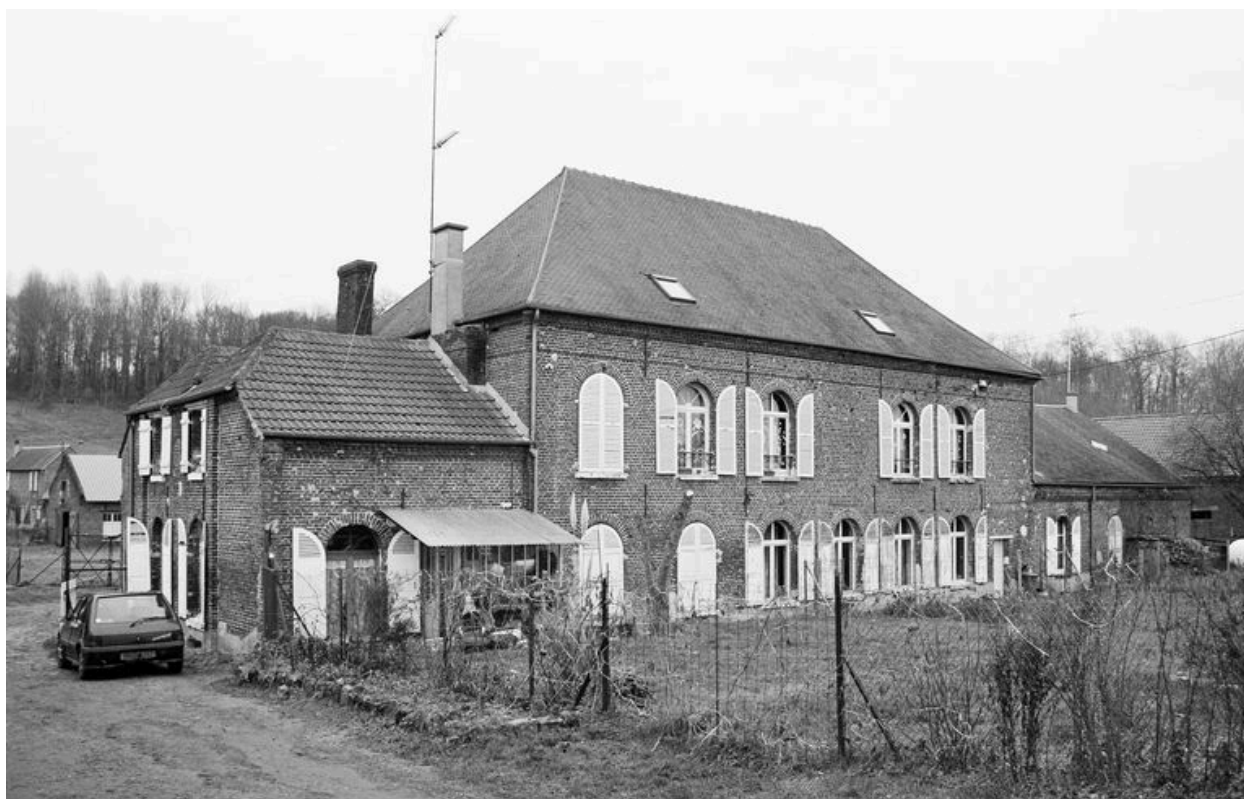
Logement patronal et bureaux : façade antérieure.
