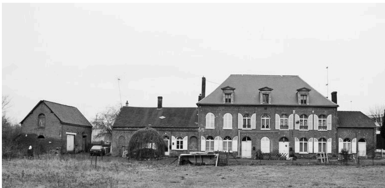
Logement patronal et bureaux : façade postérieure.
