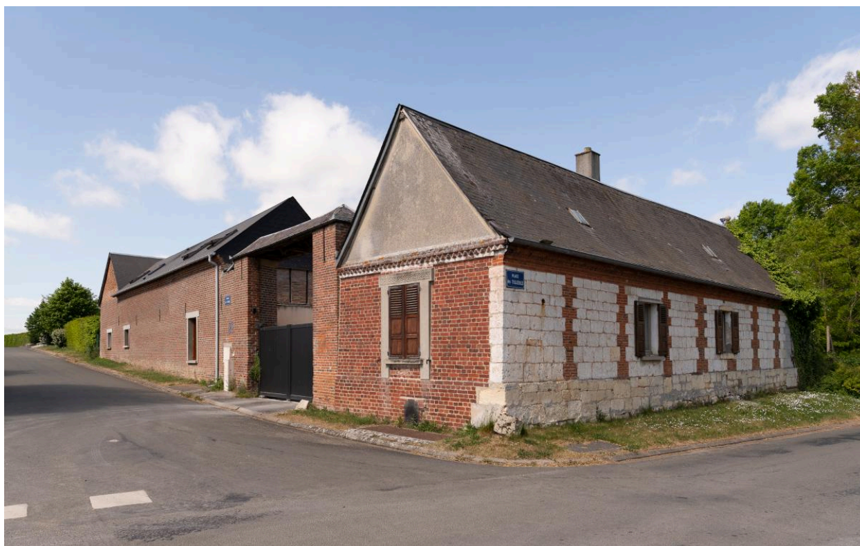
Ancienne ferme avec logis en pierre, n°2 Chemin des Vignes, vue depuis l'est.
