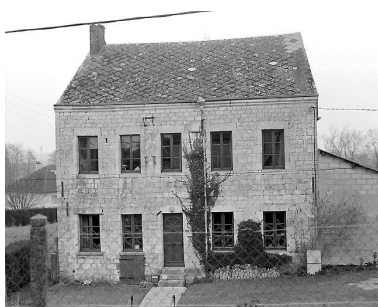
Vue générale. Phot. Laurent Jumel IVR22_19970202192X
