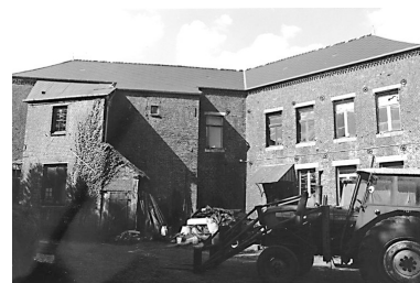
Elévation postérieure. Phot. Xavier-Philippe Guiochon IVR22_19980202685Z
