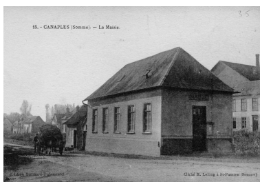
L'ancienne école de garçons abritant la mairie, 1er quart du 20e siècle (coll. part.). Phot. Monnehay-Vulliet Marie-Laure IVR22_20098000367NUCA
