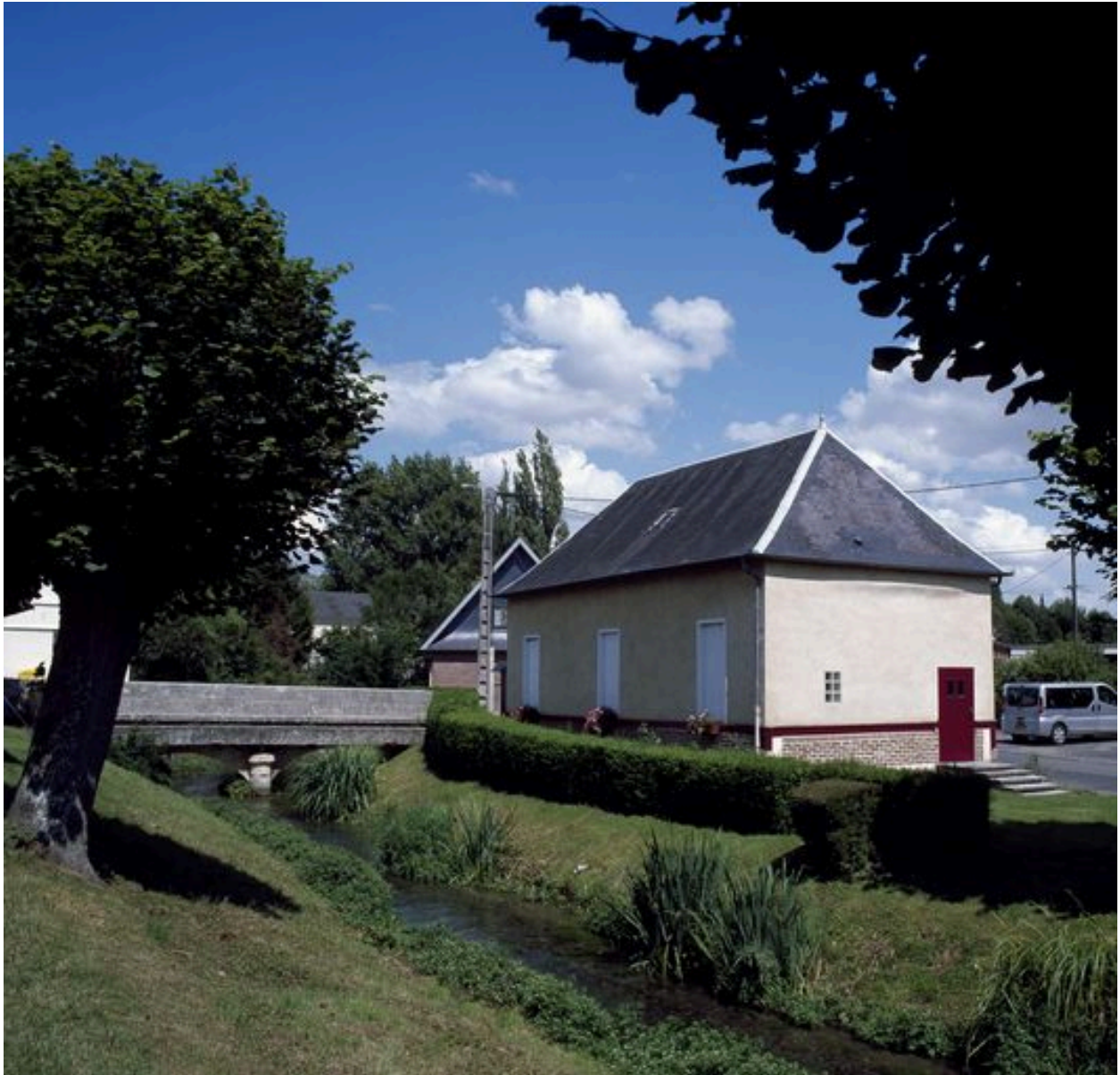
Vue générale depuis la Fieffes.
