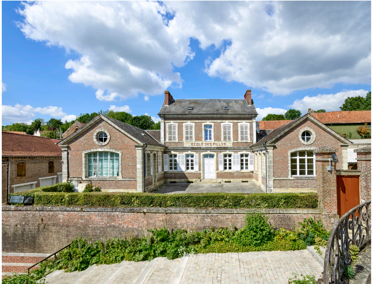
Vue de l'ancienne école de filles, depuis le sud.
