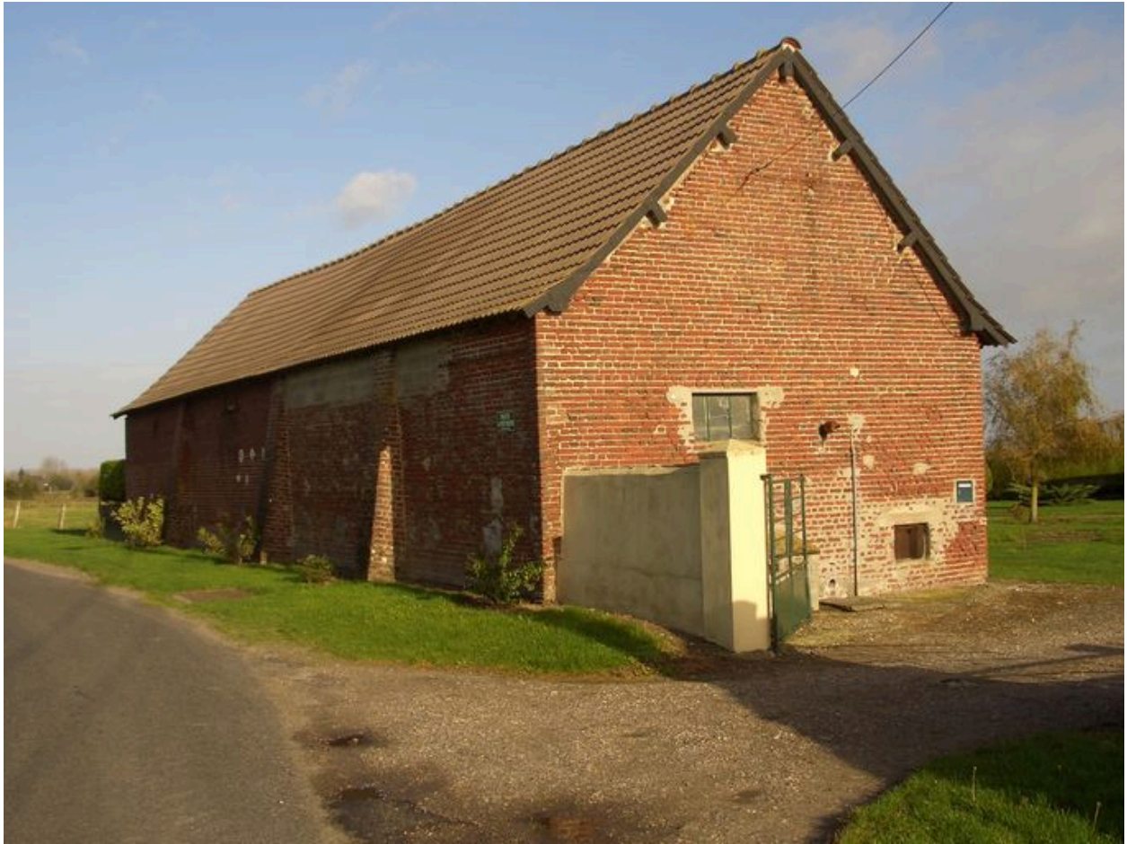
Vue de la grange sur rue.
