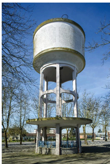
Vue générale du kiosque château-d'eau. Phot. Thierry Lefébure IVR32_20170200156NUC2A
