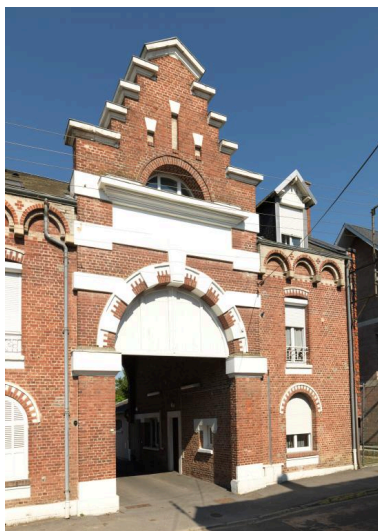
L'entrée de l'ancienne gendarmerie. Phot. Marie-Laure Monnehay-Vulliet IVR32_20188000342NUC2A
