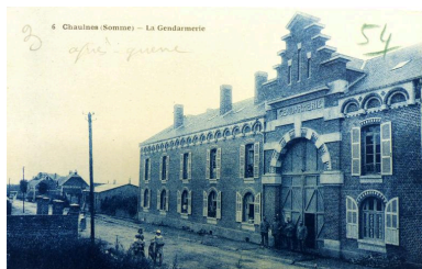
La gendarmerie après sa reconstruction. Carte postale, 1er quart 20e siècle (AD Somme ; 10R ; 311). Phot. Isabelle Barbedor IVR32_20168006540NUCA
