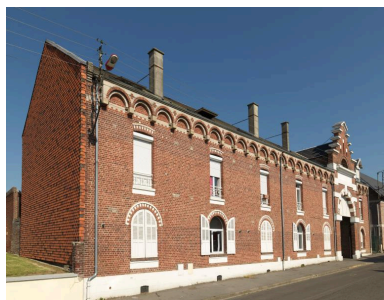
Vue générale, depuis la rue. Phot. Marie-Laure Monnehay-Vulliet IVR32_20188000341NUC2A
