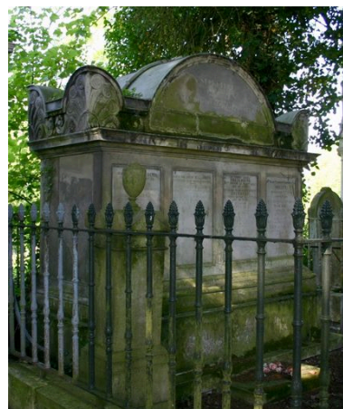
Tombeau familial, vu depuis le côté. Phot. Caroline Vincent IVR22_20088000514NUCA
