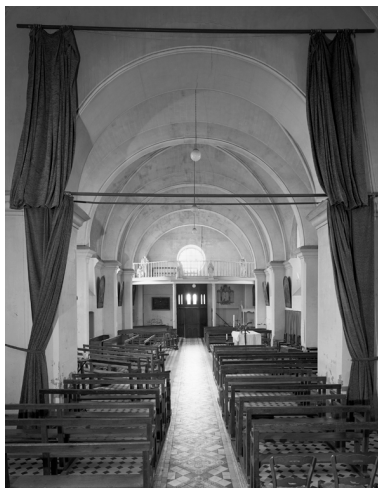
Vue intérieure, depuis le chœur. Phot. Thierry Lefébure IVR22_19930200779V
