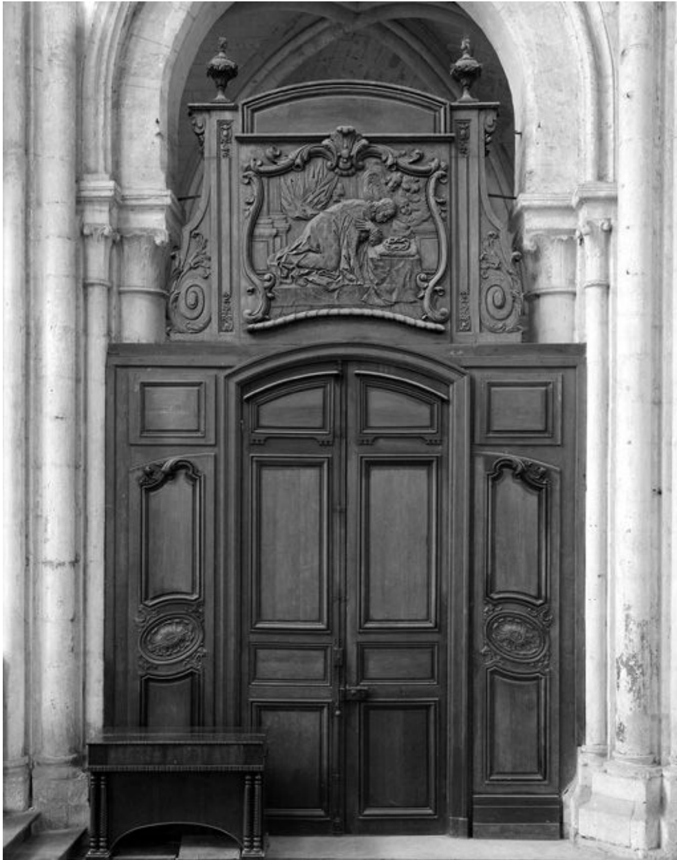
1ère travée droite du choeur côté sud. Vue d'ensemble.
