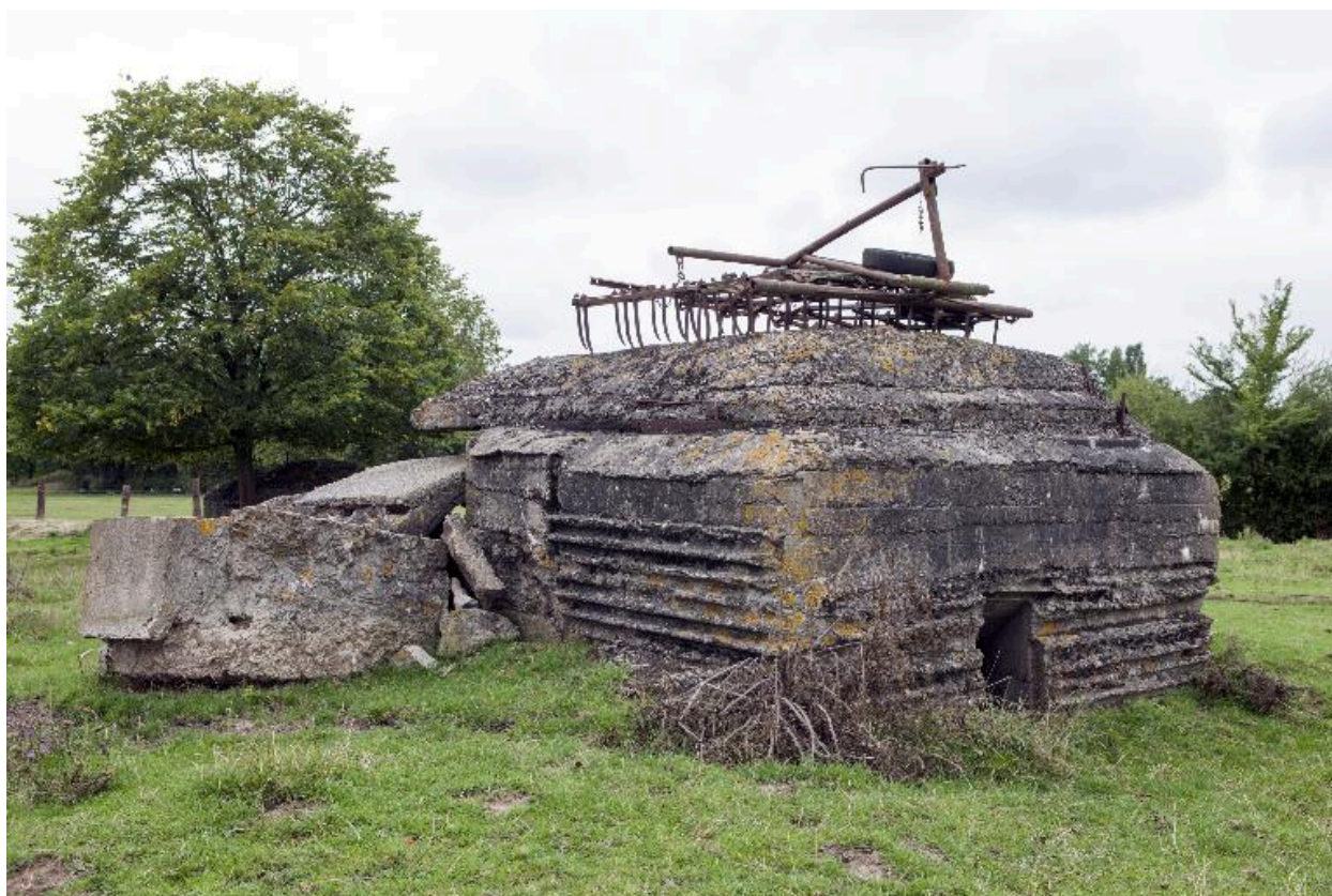
La casemate en 2015, vers l'est
