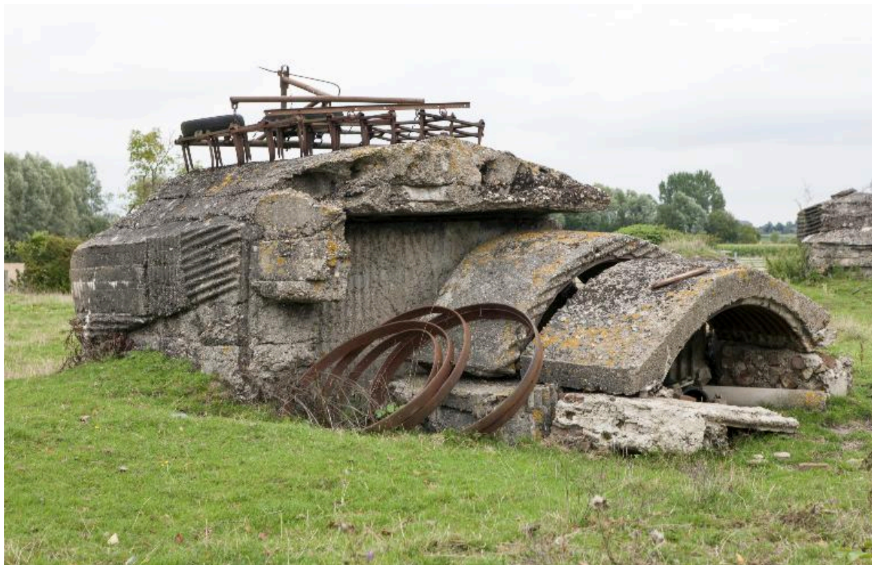
La casemate en 2015, vers l'ouest
