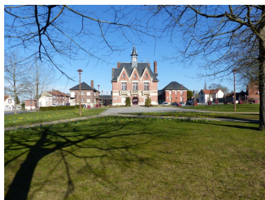
Vue de situation, depuis la place au sud. Phot. Isabelle Barbedor IVR32_20220205009NUCA
