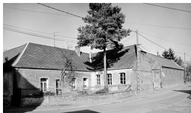
Vue partielle du logis, et de l'élévation sur rue de l'étable. Phot. Christiane Riboulleau IVR22_19940201723Z
