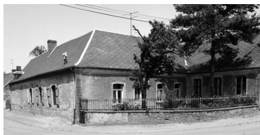
Vue d'ensemble du logis, depuis le sud. Phot. Thierry Lefébure IVR22_19920201166Z
