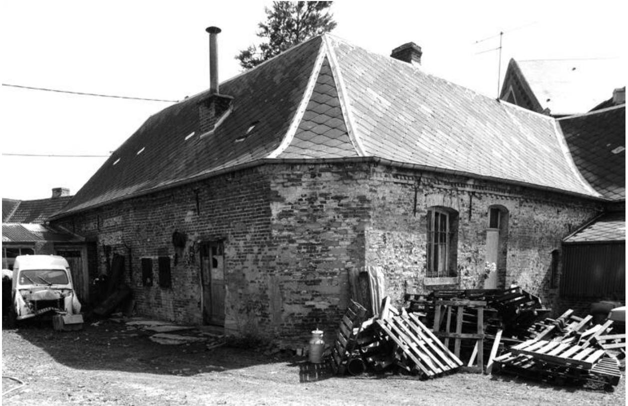
Vue partielle de l'élévation sur cour du logis.
