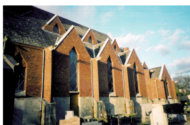
Façade latérale. Phot. Gilles-Henri Bailly IVR22_20158005742NUCA
