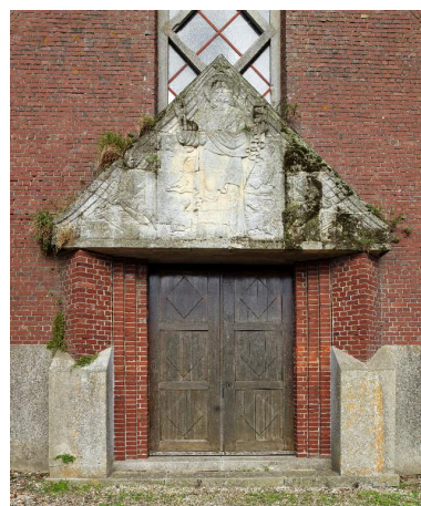
Le portail principal. Phot. Marie-Laure Monnehay-Vulliet IVR22_20158000705NUC2A
