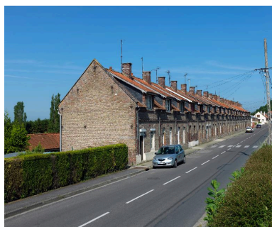
Vue d'ensemble de la cité ouvrière, façade sur rue. Phot. Thierry Lefébure IVR22_20128000277NUC2A
