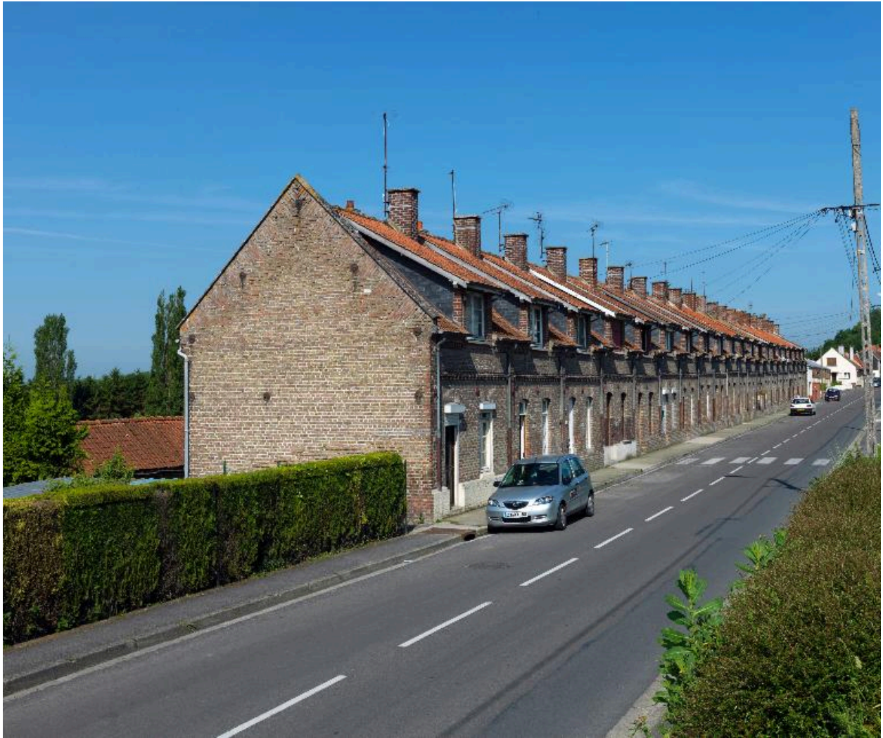
Vue d'ensemble de la cité ouvrière, façade sur rue.
