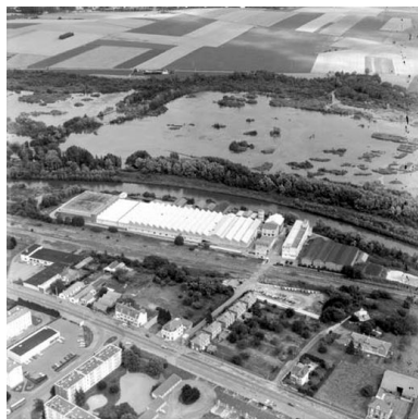
Vue aérienne, flanc sud. Phot. Phot'R IVR22_19888001303P
