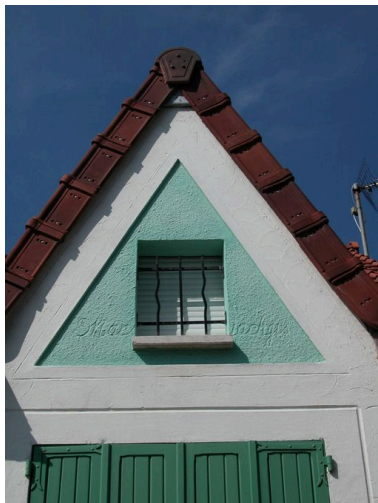
Détail du fronton triangulaire portant l'appellation en creux. Phot. Elisabeth Justome IVR22_20058002805NUCA
