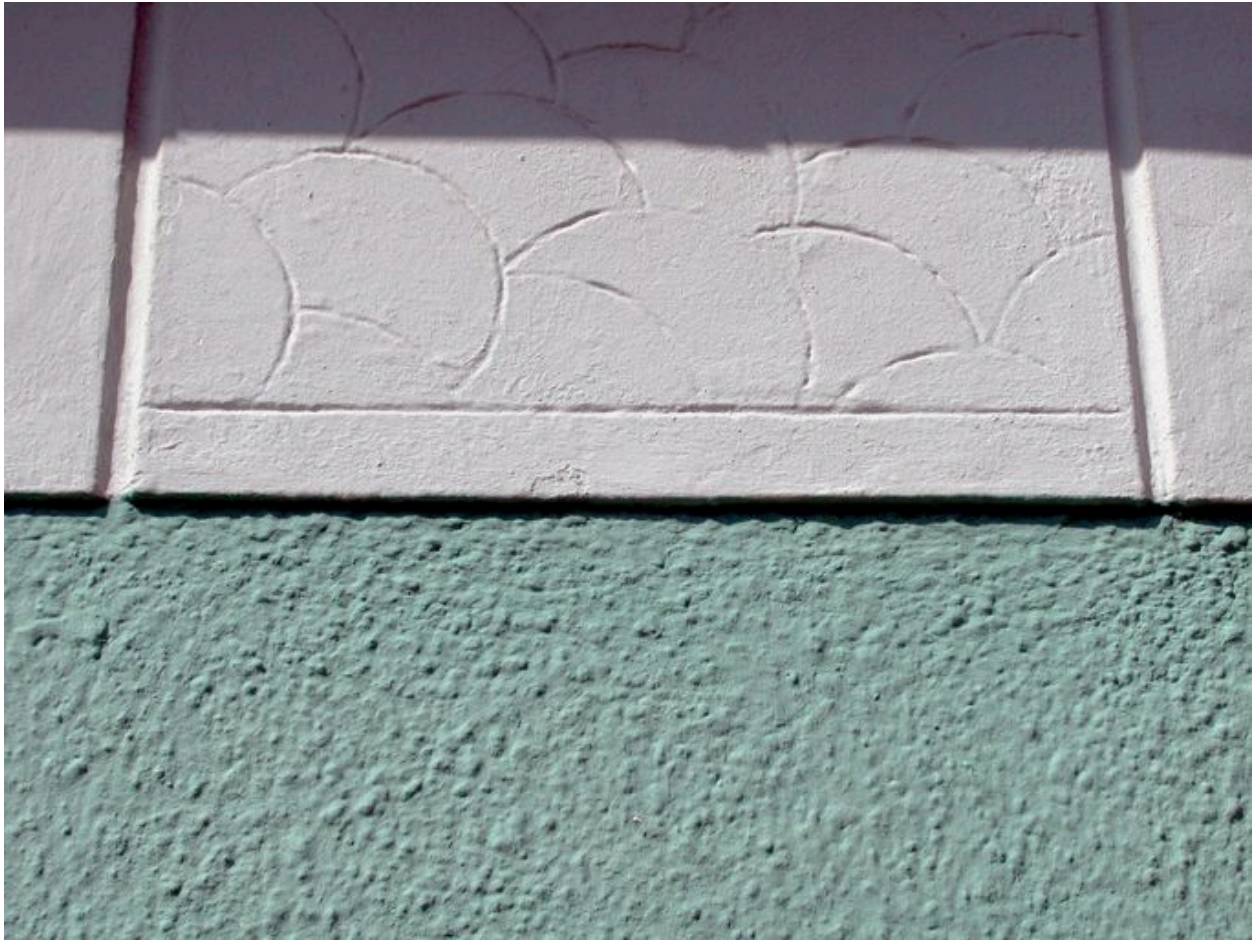
Détail du crépi et de la partie supérieure de l'élévation, avec motifs Art déco.
