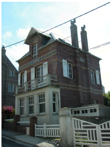
Vue d'ensemble depuis la partie basse de la rue. Phot. Elisabeth Justome IVR22_20048001690NUCA
