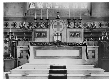
Fargniers. Église paroissiale. Le maître-autel. Photographie, vers 1930 (Archives diocésaines de Soissons). Phot. Thierry Lefébure IVR22_19910202046XB
