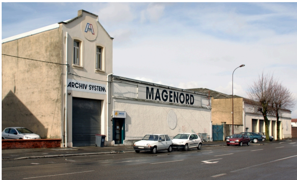
Façade antérieure de l'usine.
