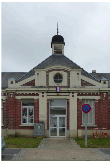
Le pavillon central du groupe scolaire. Phot. Isabelle Barbedor IVR32_20210205097NUCA
