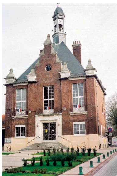
Vue générale. Phot. Gilles-Henri Bailly IVR22_20158005775NUCA
