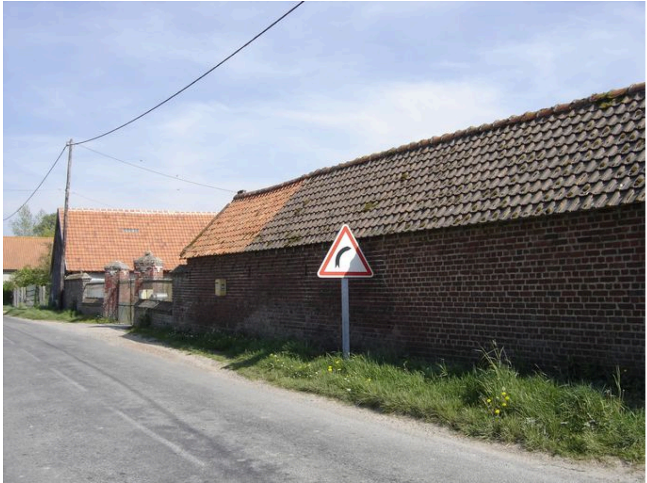
Vue d'ensemble depuis la rue du Hamelet.
