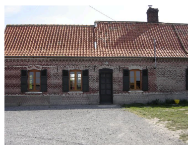
Vue du logis et des écuries attenantes. Phot. Inès Guérin IVR22_20078005954NUCA
