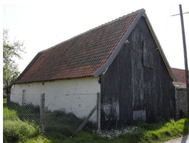
Vue postérieure des étables. Phot. Inès Guérin IVR22_20078005956NUCA
