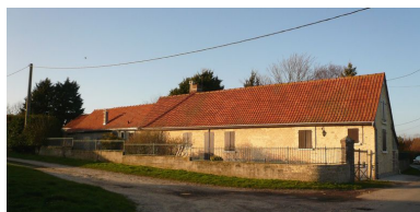
Vue générale. Phot. Inès Guérin IVR22_20058006386NUCA
