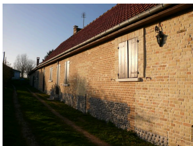
Vue détaillée de la partie habitable. Phot. Inès Guérin IVR22_20058006387NUCA
