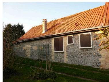
Vue détaillée de la partie écurie. Phot. Inès Guérin IVR22_20058006388NUCA
