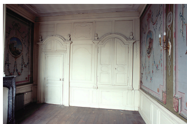
Vue générale du mur garni de lambris de hauteur ; à gauche, la porte surmontée d'un petit placard, à droite, le grand placard.
