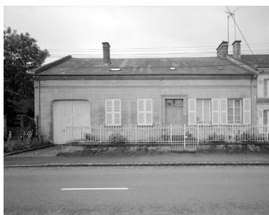
Elévation antérieure. Phot. Jean-Michel Périn IVR22_19856000804V
