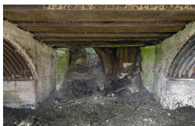
Intérieure de la chambre de tir, vers le nord Phot. Jean-Marc Ramette IVR32_20165901003NUCA
