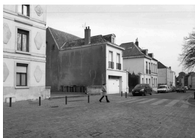
Place Verte, côté nord-ouest : vue générale de l'ensemble des hôtels. Phot. Pierre Thibaut IVR31_20065900251X
