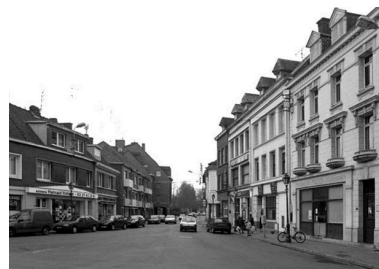
Rue de l'Escaut : vue depuis la place Pierre-Delcourt dont la rue forme le débouché. Phot. Pierre Thibaut IVR31_20065900257X
