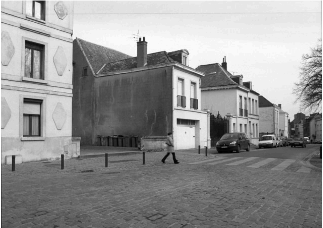
Place Verte, côté nord-ouest : vue générale de l'ensemble des hôtels.
