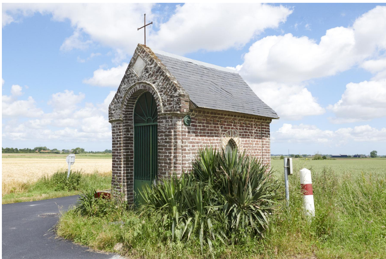
Vue façade et côté sud-est.
