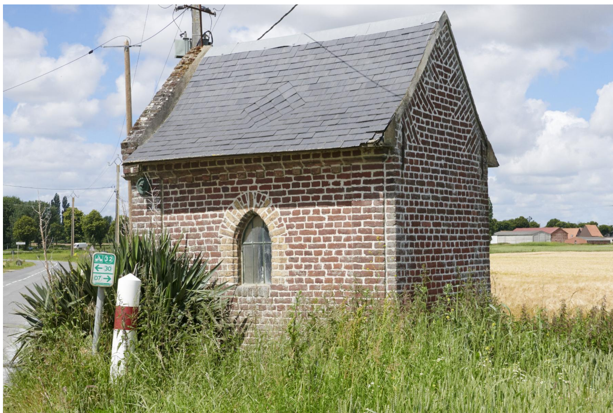
Vue arrière et côté sud-est.
