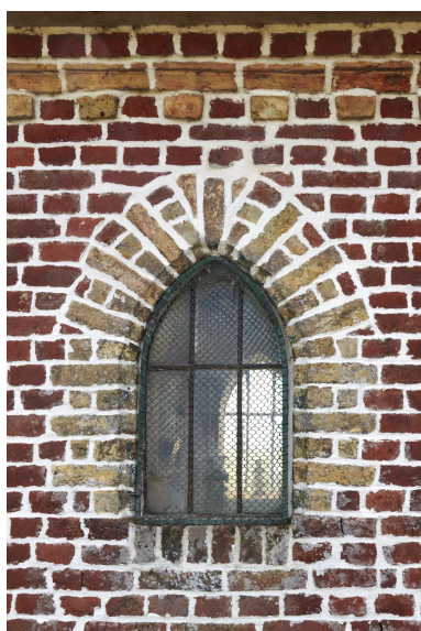
Baie côté nord-ouest. Phot. Delphine Volto-Jourdan IVR32_20245902313NUCA
