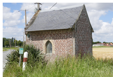
Vue arrière et côté sud-est. Phot. Delphine Volto-Jourdan IVR32_20245902314NUCA
