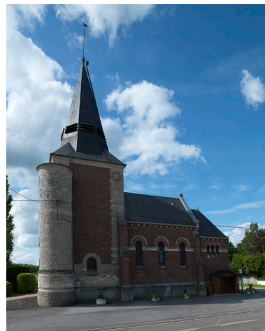
Vue générale depuis le sud. Phot. Marie-Laure Monnehay-Vulliet IVR22_20148000389NUC2A
