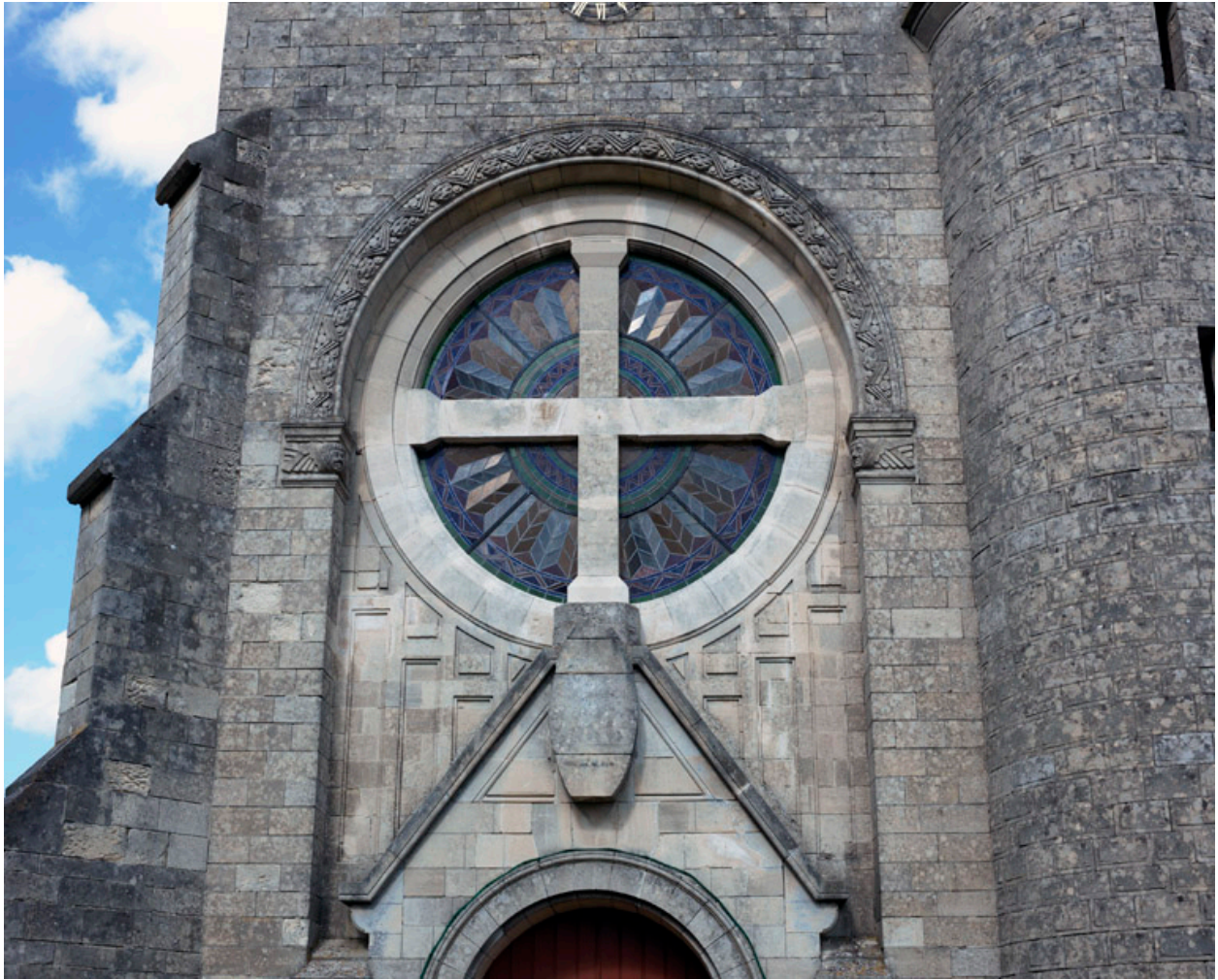
Vue de détail de la façade principale.
