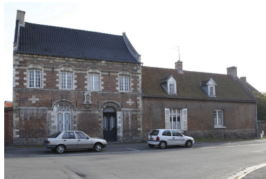
Vue générale. Phot. Pierre Thibaut IVR31_20095903400NUCA
