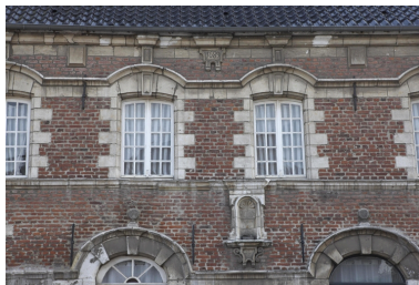
Étage carré avec cartouche portant la date (1689) et la niche destinée à accueillir la statue de Saint-Michel (disparue). Phot. Pierre Thibaut IVR31_20095903402NUCA
